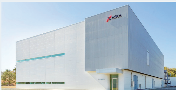
第四製剤棟(いわき工場)
